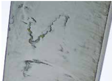
Foto 4. Aerolaminat vinge. Revner i overfladen forårsaget af delaminering på vingetoppen.
