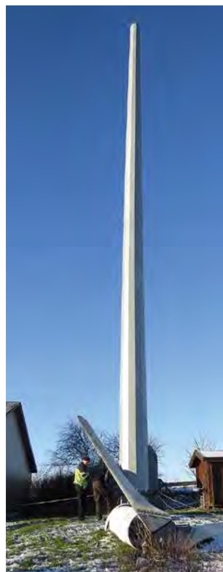
Havari af Kingspan 6 kW
