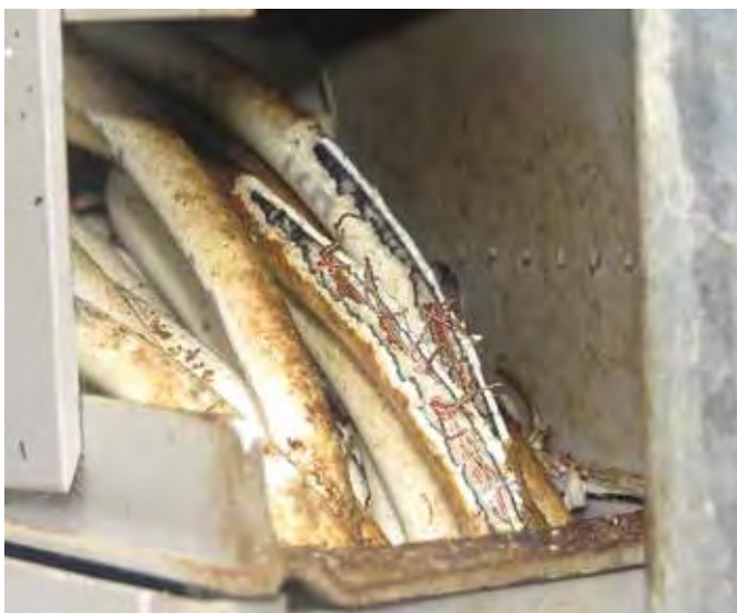
Til venstre: Ledninger til måleren. Isoleringen er gnavet helt væk ind til kobberet. Foroven: Isoleringen er gnavet af højspændingskablerne.
