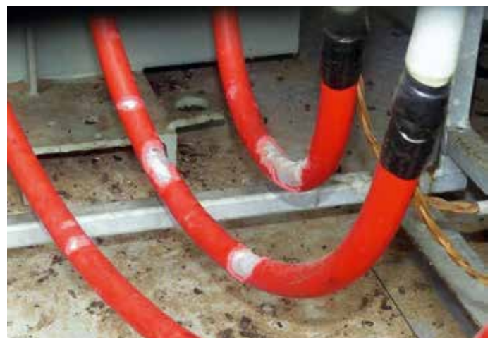
Til venstre: Ledninger til måleren. Isoleringen er gnavet helt væk ind til kobberet. Foroven: Isoleringen er gnavet af højspændingskablerne.
