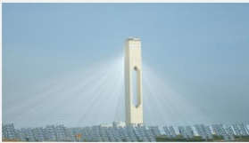
Concentrated Solar Power (CSP) er også i fremgang, dog ikke så meget som PV.
